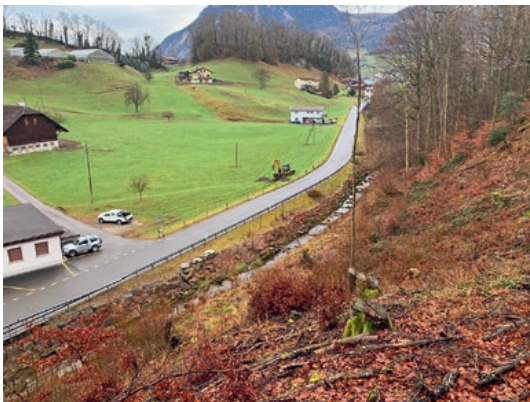
Situation Installationsplatz im Februar 2024
