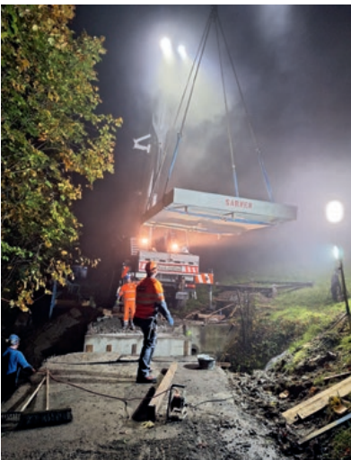
Versetzen der neuen Brückenteile
