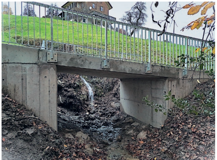
Fertige Brücke unten
