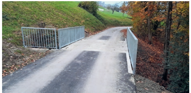
Fertige Brücke oben
