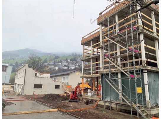
Abbruch Schulhaus 4, Rückbauarbeiten Gemeindehaus
