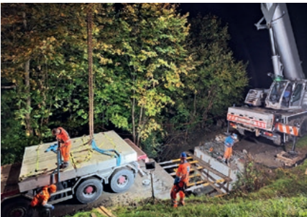
Anlieferung der neuen Brücke
