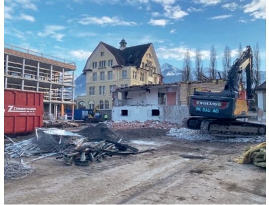
Abbrucharbeiten Schulhaus 4 (ehemals «Schulinsel»)
