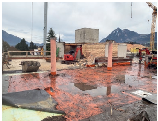
Abbruch Attikageschoss Gemeindehaus
