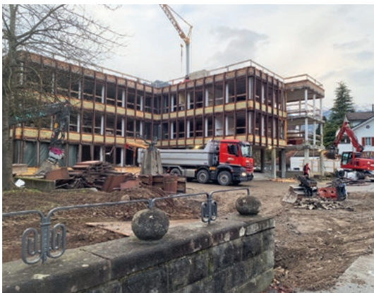
Abbruch Fassade Gemeindehaus und Umgebung
