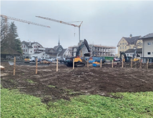
Erstellung Lagerplatz Aushubmaterial und provisorische Parkplätze Restaurant Aiola
