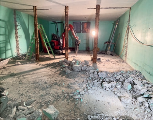
Teilabbruch alte Zivilschutzanlage Gemeindehaus
