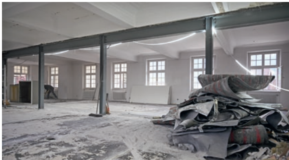
Wo früher Büroräume waren, ist jetzt ein grosser Raum.
