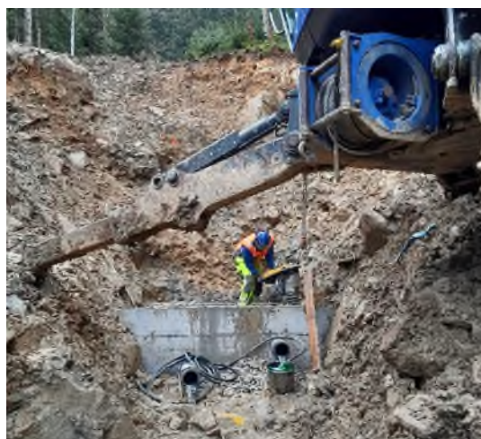
Sanierung Quelfassung Schälfl Ramersberg
