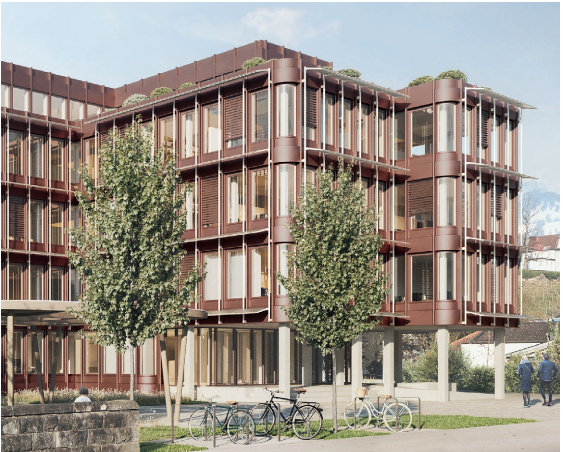
Visualisierung Fassade Gemeindehaus mit «Brissoleils» (Sonnenbrecher)
