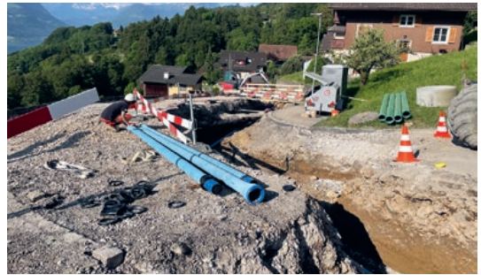
Während den Bauarbeiten
