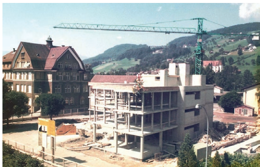
Baustelle Neubau Gemeindehaus 1974
