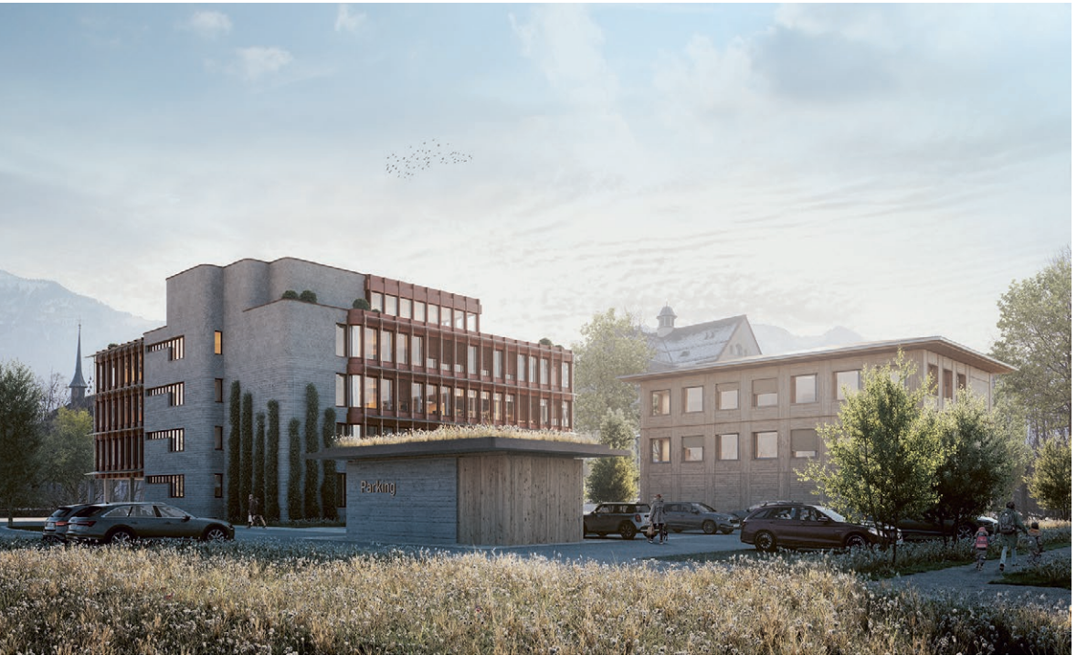
Visualisierung Nord/West-Ansicht Gemeindehaus, Parkinggebäude mit Personenaufgang, Lift und öffentlichem WC sowie Multifunktionsgebäude
