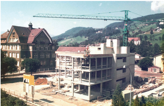
Baustelle Neubau Gemeindehaus 1974
