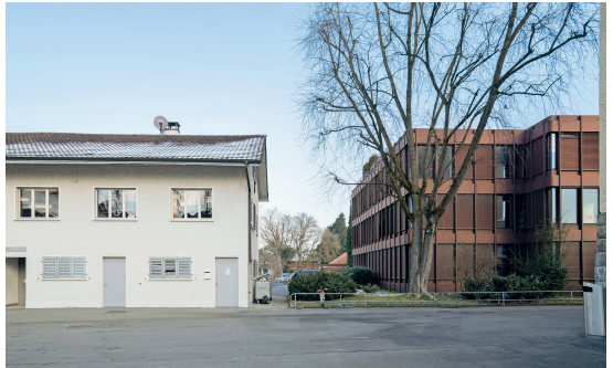
Schulhaus 4 links und Gemeindehaus rechts (Stand 2023)
