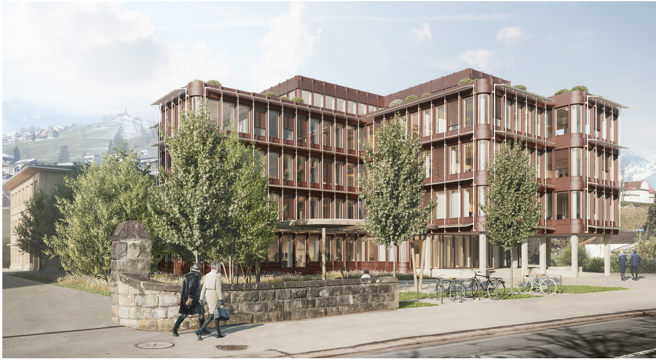
Gemeindehaus, im Hintergrund das Multifunktionsgebäude.
