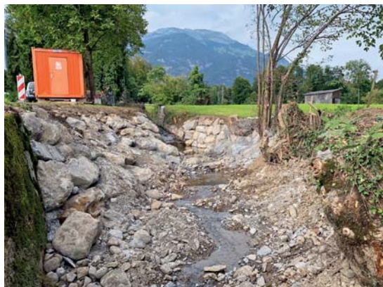
Chli Schlierli Sammlerauslauf nach Bauausführung
