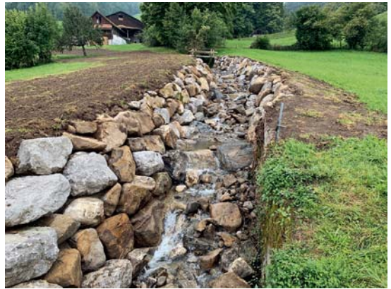
Schatzlibach nach Ausführung der Unterhaltsarbeiten
