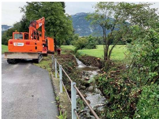
Chli Schlierli Sammlerauslauf vor Baustart
