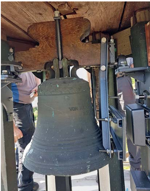
Neue Geläutanlage im Glockenturm
