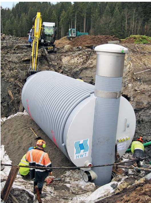
Versetzen Brunnstube Brunnmatt
