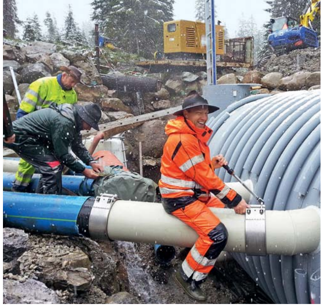
22. Mai 2016: Montage Brunnstube «Gerenstock»
