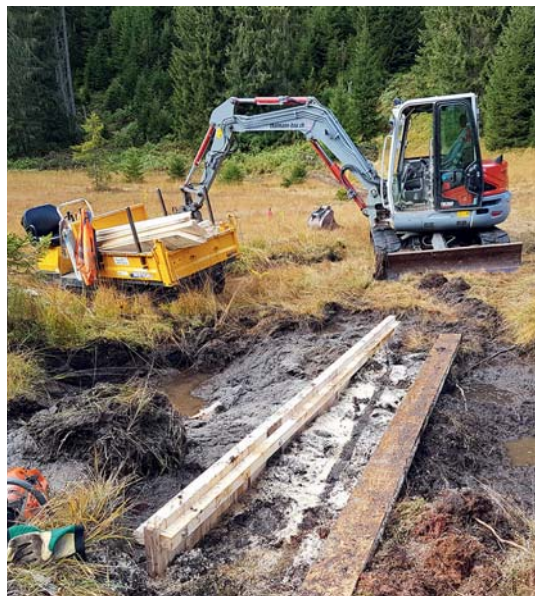
Bau einer Holzstaumauer zur Hochmooraufwertung Häsiseggboden im Herbst 2019
