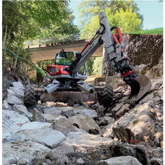
Sperrensicherung mit Raubettgerinne. Zur Sicherung der Stützmauer wurde ein Blocksatz erstellt.
