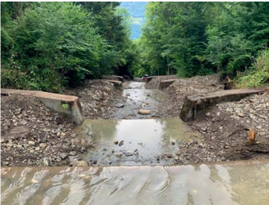
Wiederherstellung Abflussprofil Schlimbach. Sperrtreppen Talen-Hostett
