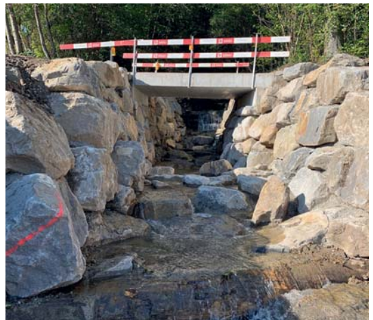
Raubbettgerinne, Blocksatz und Brücke Margistrasse fertig erstellt
