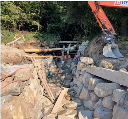
Bau Raubbettgerinne und Blocksatz
