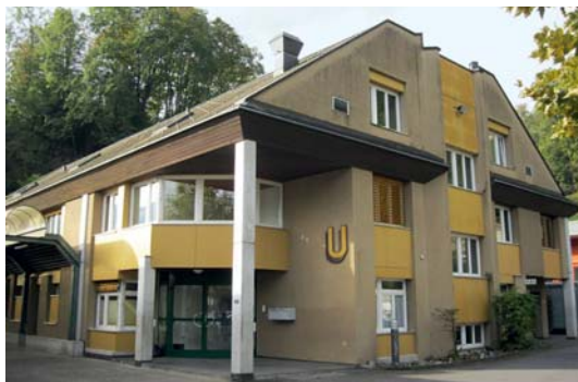
Mehrzweckanlage Ei vor der Sanierung
