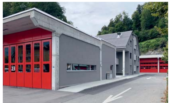
Totalansicht sanierte Gebäudegruppe von vorne nach hinten: Feuerwehrrhalle 2, Mehrzweckanlage Ei, Feuerwehrrhalle 1
