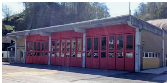
Feuerwehrrhalle 2 (ehemaliges Hauptgebäude der Feuerwehr) vor der Sanierung
