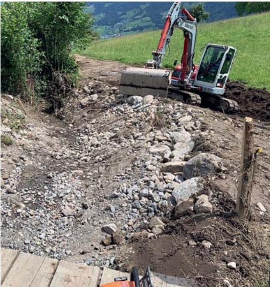
Wiederherstellung Abflussprofil Golpigräbli
