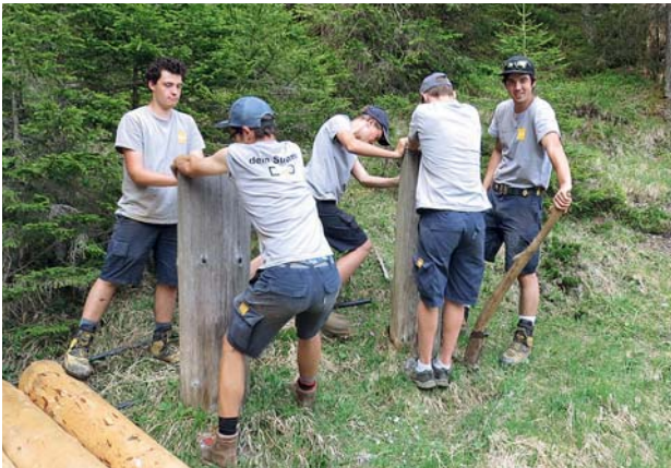
Elik Egger, Raphael Steiner, Severin Kiser, Robin von Rotz und Stefan Rohrer ersetzen die alten Baumstämme durch neue.
