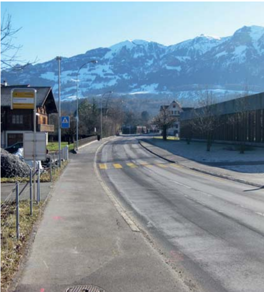
Rütistrasse, Bereich Bushaltestelle «Kantonsschule»
